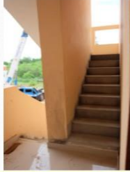
บันไดหนีไฟ
